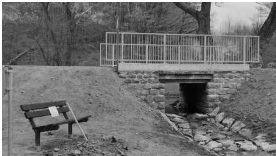
Propustek v tělese cyklostezky
