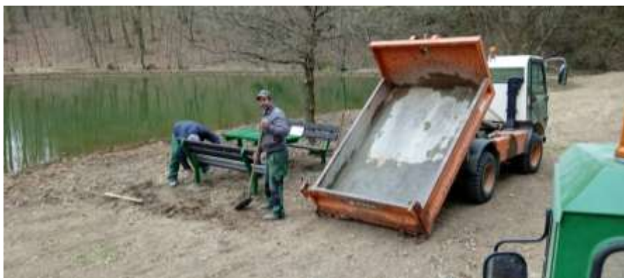
Instalace laviček u mokřadu Kněží
