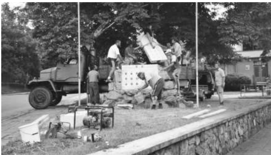
Demontáž památníku před obecním úřadem
