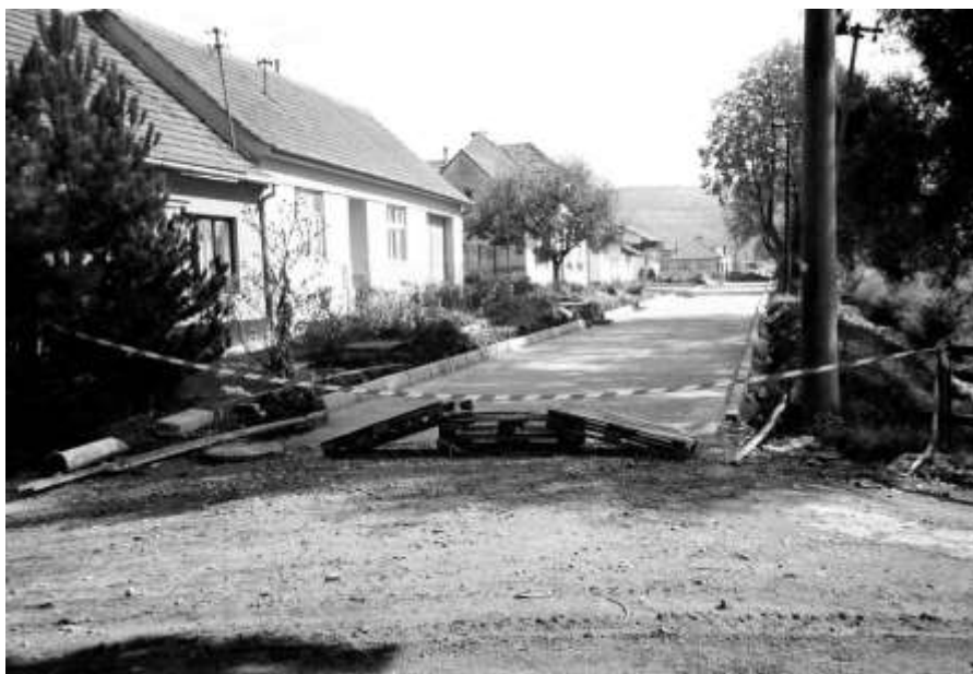
Pohled na stavbu komunikace Na Hrázi od mostu z Uličky
