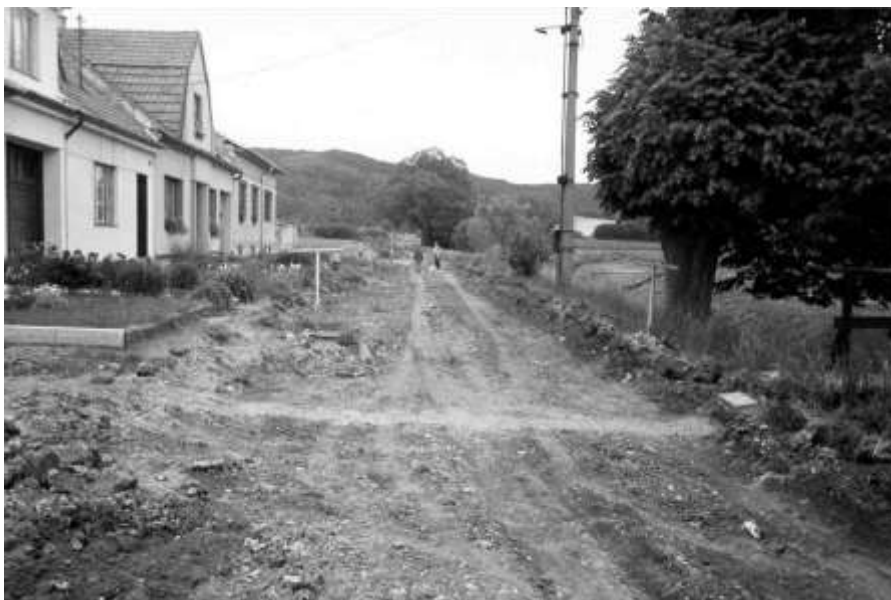
Budování komunikace v ulici Na Hrázi
