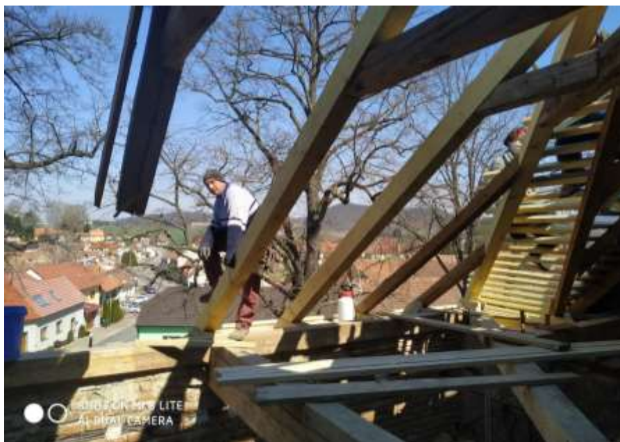
Oprava střechy kostela sv. Markéty pokračuje také díky dotaci obce
