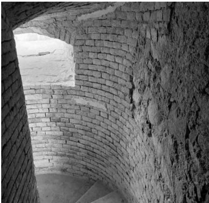
Napojení nového zdiva na kamennou zeď ve věži kostela sv. Markéty
